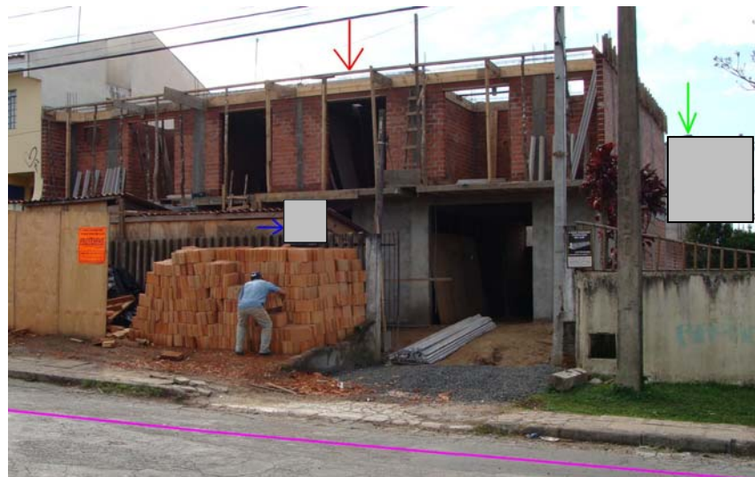
Figura 14 - Vista da parte 1 da obra (seta vermelha ), voltada para a rua (eixo indicado pela linha lilás ). Ao fundo, vista parcial da casa examinada (seta verde ). A seta azul indica a placa de identificação do profissional responsável técnico pelo projeto e pela execução da obra (detalhada na figura a seguir).
