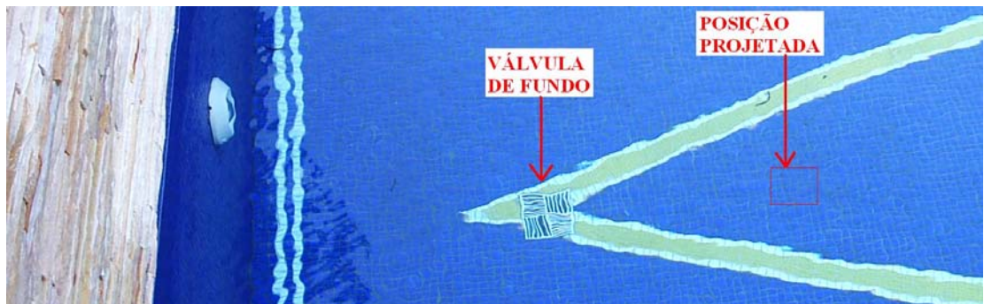
Figura n.º 24 – Tomada fotográfica da válvula de fundo da piscina
