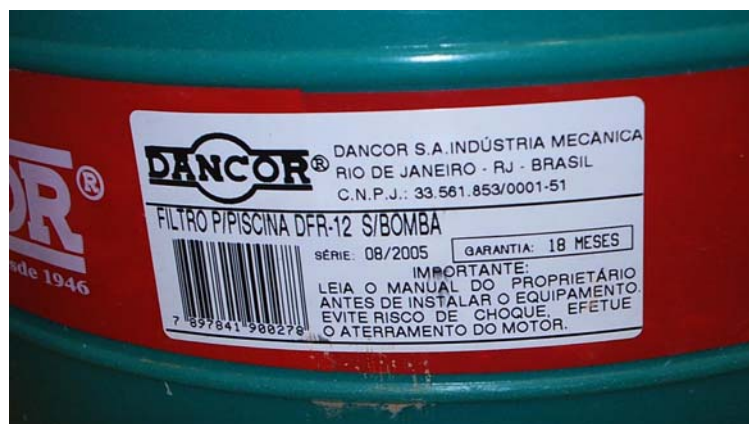
Figura n.º 16 – Etiqueta de identificação do filtro da banheira do spa da marca Dancor, modelo DFR-12;
