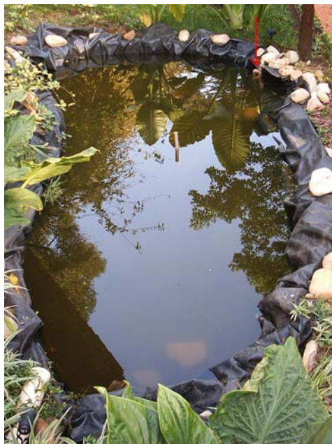
Figura 5: tomada fotográfica da cisterna mostrando a posição do tubo de referência para medição do nível da água (seta vermelha).
